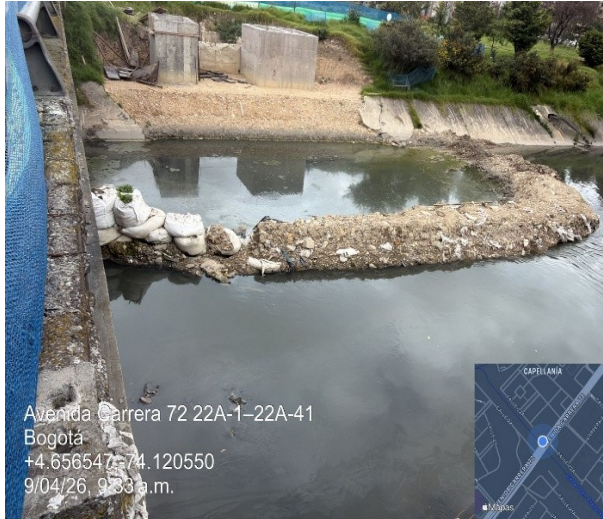
Fotografía No. 5. Vista lateral, desvío temporal, cajas de inspección costado sur y lozas a renovar canal San Francisco.
